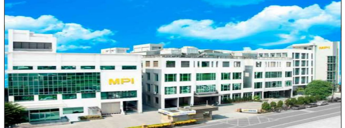
● MPI旺矽科技股份有限公司-湖口新廠基礎機電工程
