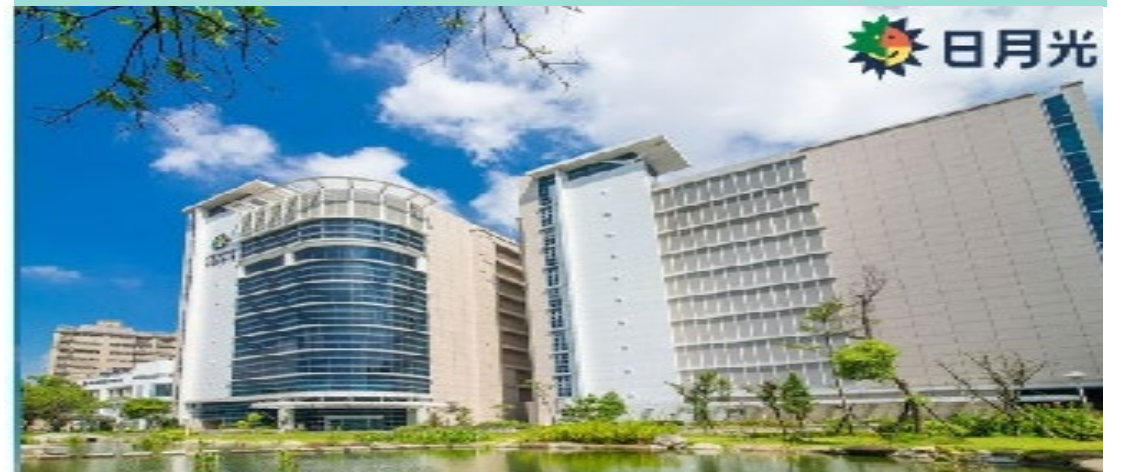
● ASE日月光半導體製造(股)公司-空調及製程系統管路1至1.5側工程
