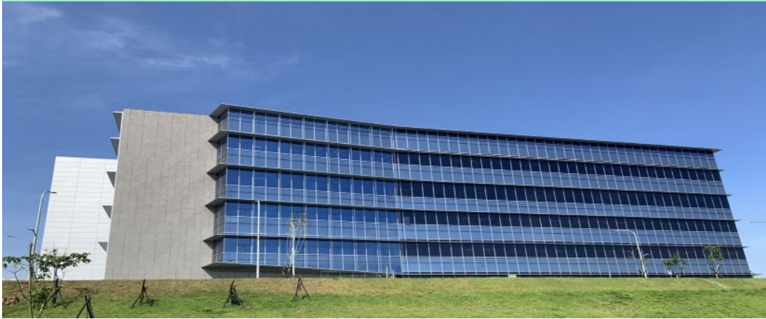
● KYEC京元電子銅鑼三廠-機電及消防工程
