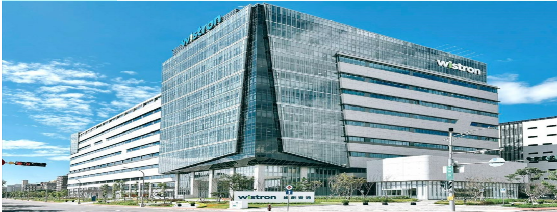
● Wistron緯創資通(股)公司-竹北AI園區機電工程
