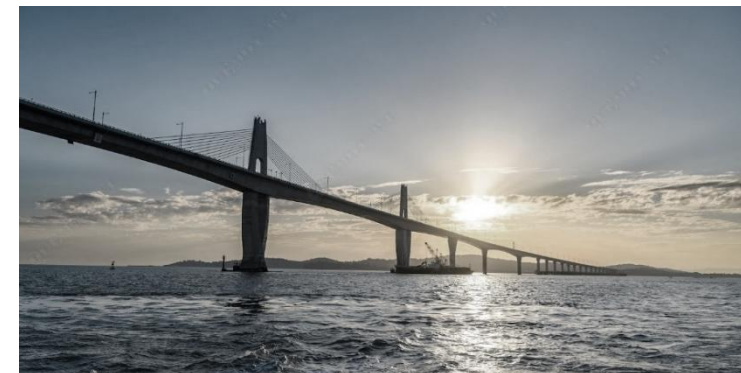
金門大橋 - 脊背橋 Kinmen Bridge
