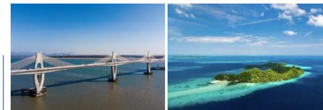
2023 金門大橋結構監測 帛琉複合式環境監測
